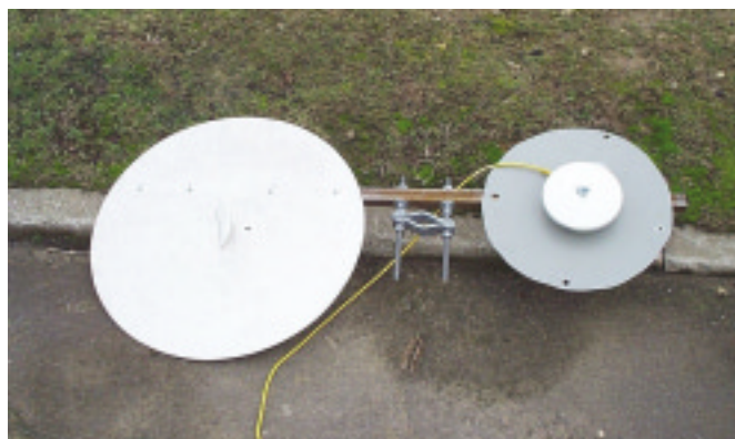
Figure 5 - Montage du transpondeur et de l'antenne GPS
