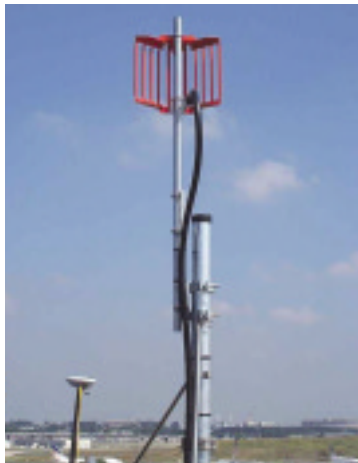
Figure 4 - Relevé d'une antenne
